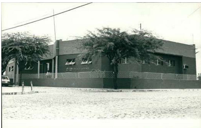
Foto 7 - Fachada da Agência de Nova Russas (CE) - 1969
